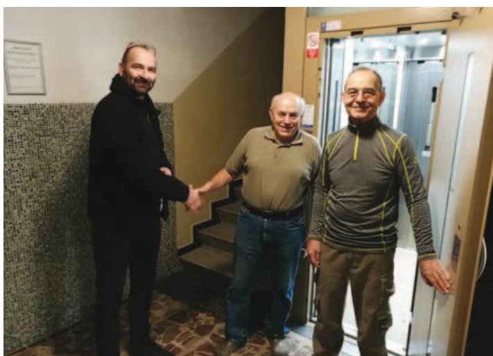
Zleva pan Pavel Ševčík za realizační firmu HELGOS, Ing. Pavel Kubík, předseda SVJ a člen výboru pan Martin Petřů během závěrečné kolaudace. Za povšimnutí stojí tabulka na zdi v levém horním okraji snímku. Je to jedna z podmínek poskytnutí dotace. Nese tento text: „Výtah byl vybudován v rámci programu 117D06 – Podpora bydlení, Bezbariéry – Děčín, Řecká 1450/12. Tento projekt byl spolufinancován z prostředků Ministerstva pro místní rozvoj. Výtah byl dokončen a předán do užívání dne 29. listopadu 2018.“
